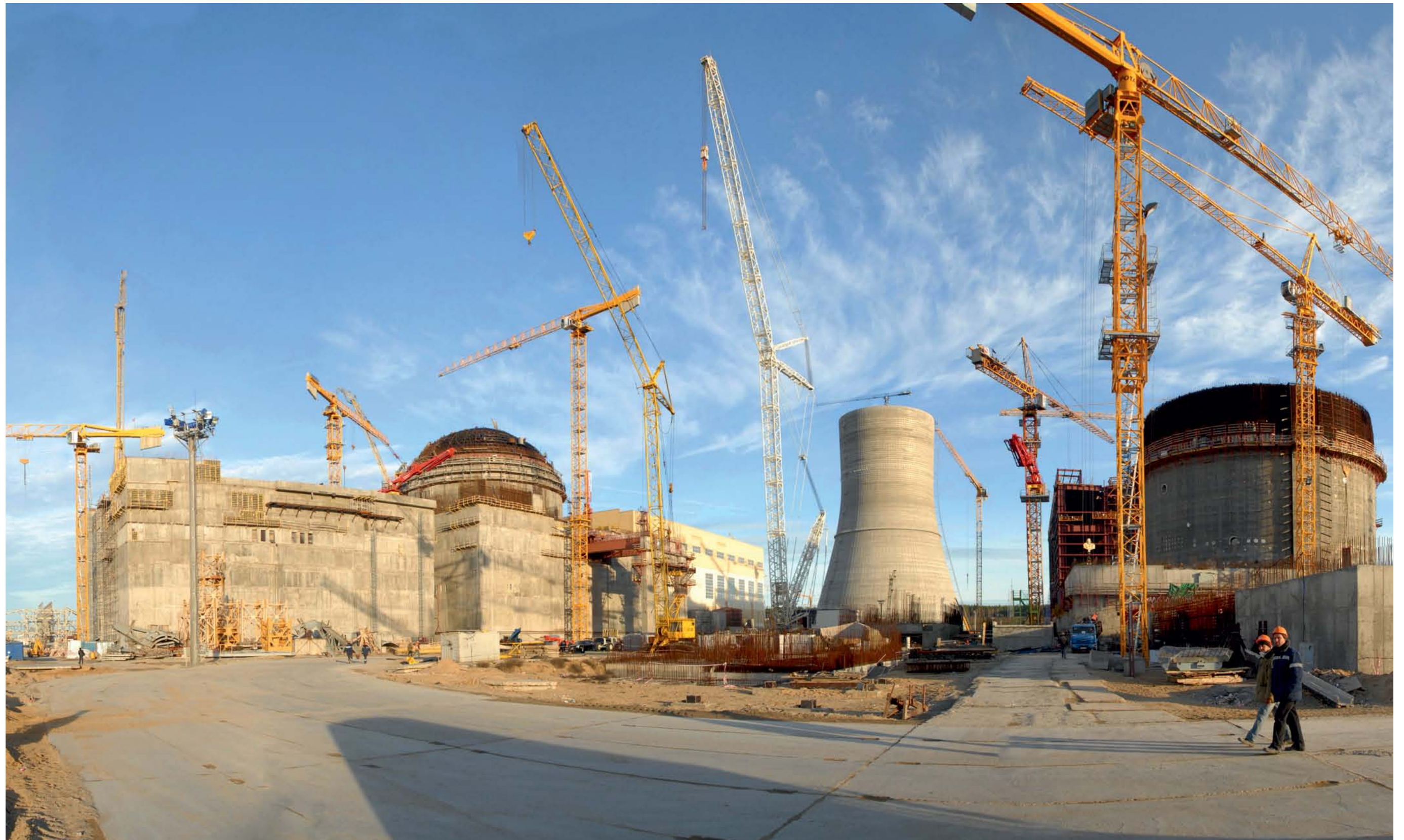
Площадка строительства Нововоронежской АЭС-2
