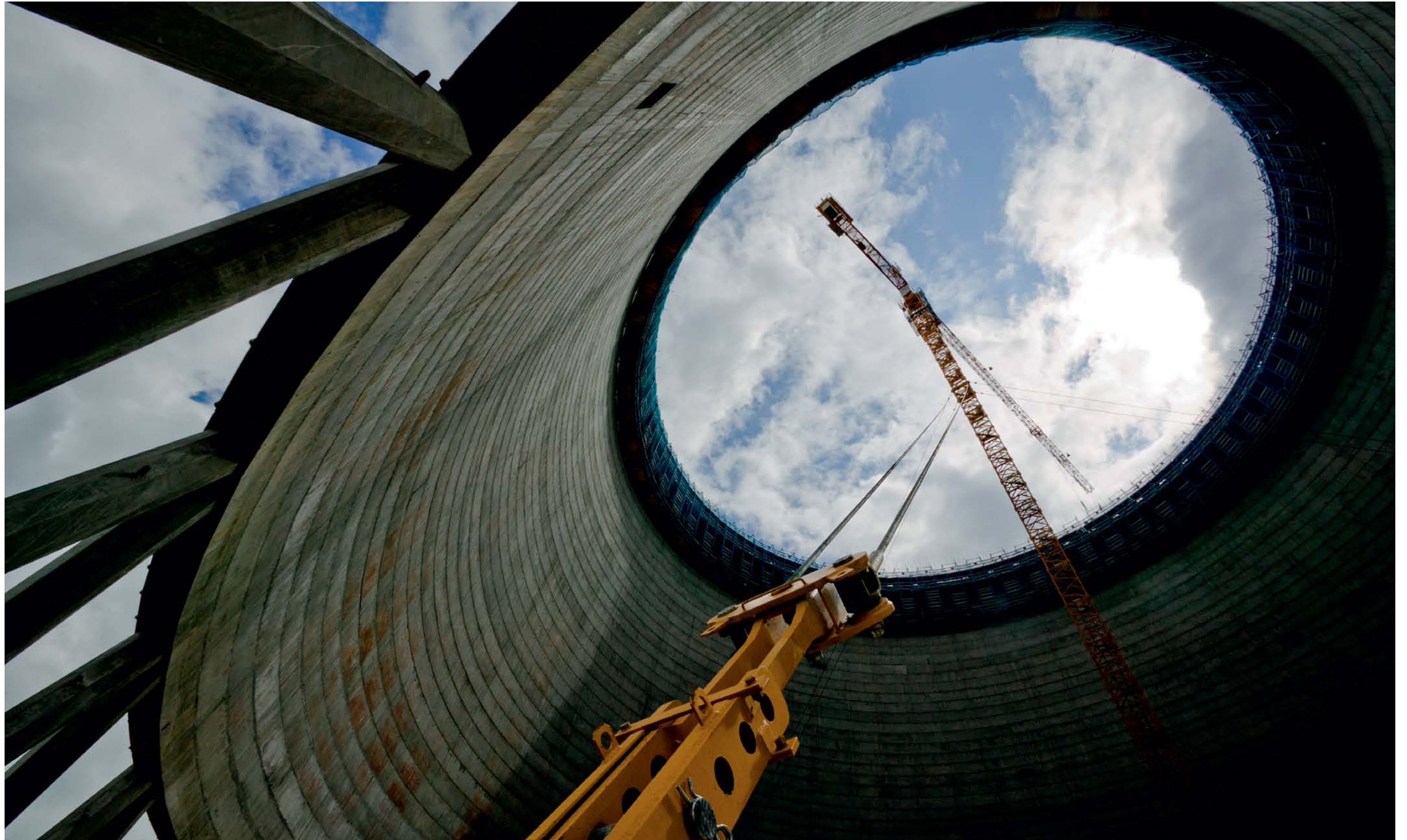
Верхний ярус градирни строящегося энергоблока №4 Калининской АЭС, 2009 г.
