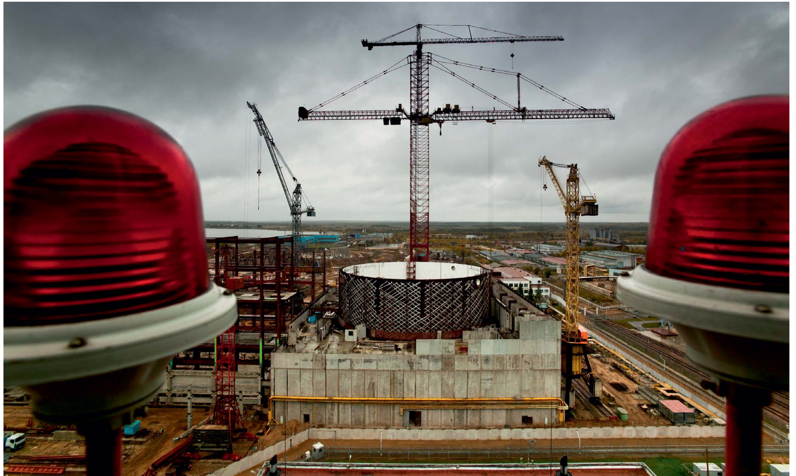
На стройплощадке энергоблока №4 Калининской АЭС, 2011 год
